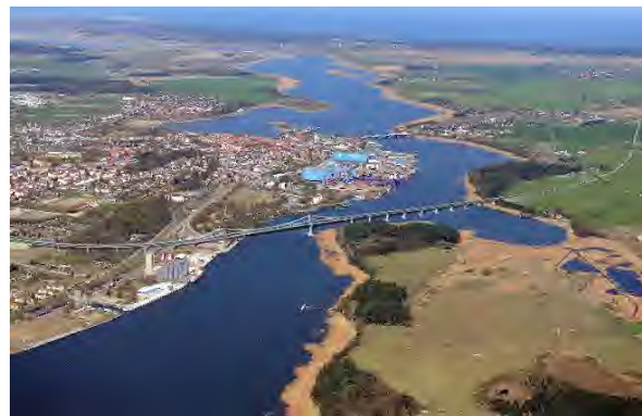
Peenestrom-Querung / ©Deges Deutsche Einheit Fernstraßen-Planungs- und -Bau GmbH
