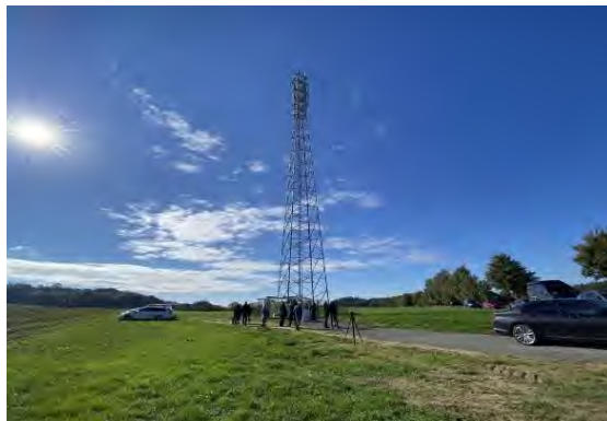
Erster fertiggestellter Funkmast – Göllin / ©Funkmasten-Infrastrukturgesellschaft MV mbH
