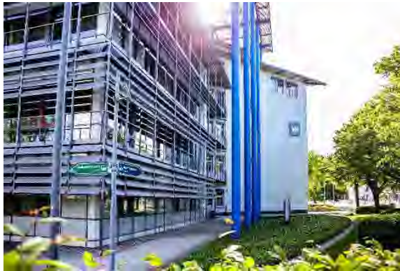
DVZ-Haus / ©DVZ Datenverarbeitungszentrum M-V GmbH
